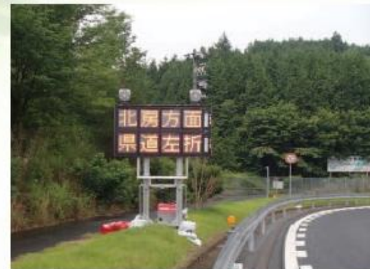
専用の架台を用いた設置例 (携帯型情報板 2台を使用)
