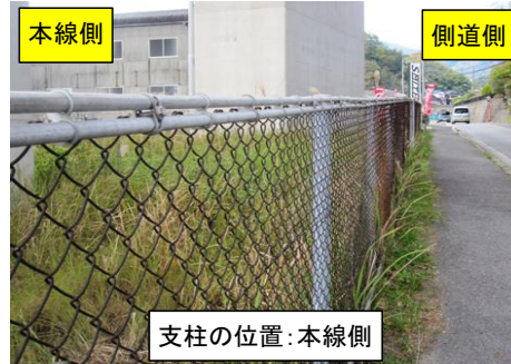
写真3. 立入防止柵支柱の位置確認
