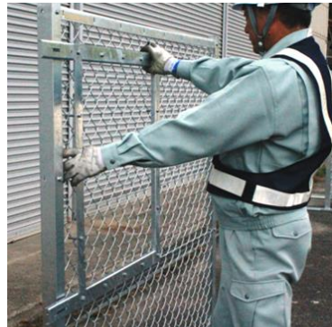
写真4. サブフレームの設置
