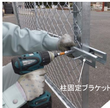
写真5. 支柱部の固定
