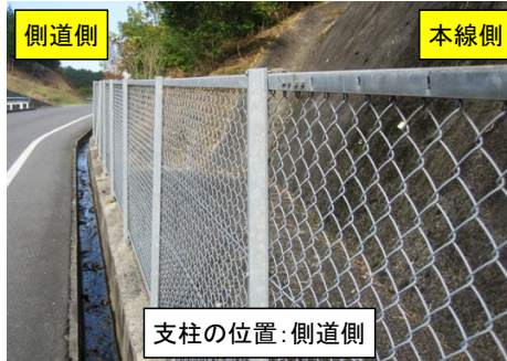
写真3. 立入防止柵支柱の位置確認
