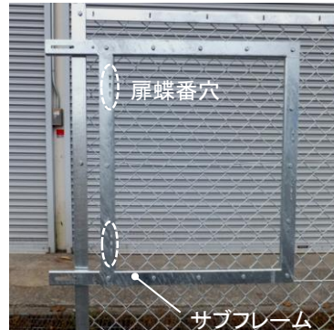
写真4. サブフレームの設置
